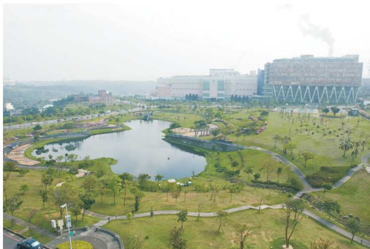
公園四調節池全景。
