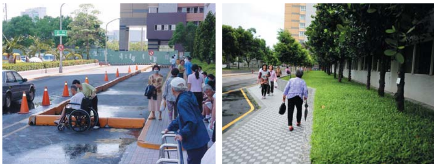
圖七 拓寬人行步道取代路緣石
