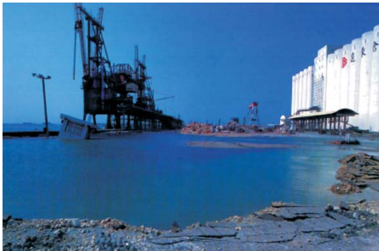
照片二 地震造成碼頭護岸設施倒塌
