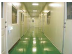
恆溫、恆濕、無塵中央走廊
