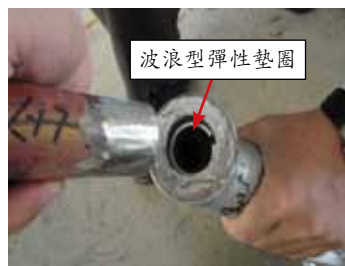
(2) 再將管材插入到底，即可焊接。
