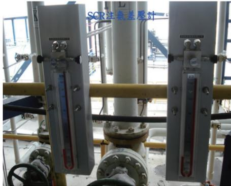
▲參考現有監測設備 - 注氨差壓計數值、NO<sub>x</sub> 入口濃度及煙囪 NO<sub>x</sub> 濃度等數值來判斷注氨量。
