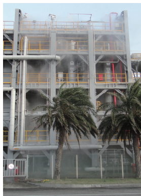
▲圖 7. 製程區水霧啟動情形
