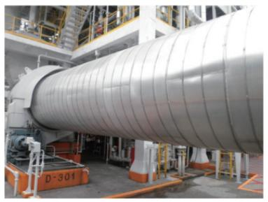
效果，以減少能源之逸散損失 ( 效益：每年減少 430 噸蒸氣損失 )。
