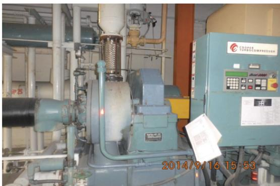
▲圖 3: 雙氧水製程空壓機照片
