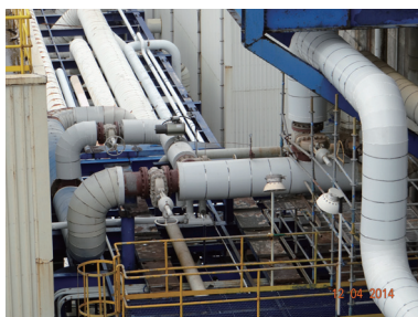
▲圖 4 於 2\text{KG}/\text{CM}^2 蒸汽入汽機發電前增設壓控閥，提高其背壓至 2.5\text{KG}/\text{CM}^2 取代部分 4.5\text{KG}/\text{CM}^2 蒸汽使用
