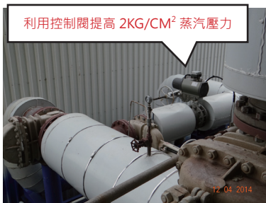
▲圖 4 於 2\text{KG}/\text{CM}^2 蒸汽入汽機發電前增設壓控閥，提高其背壓至 2.5\text{KG}/\text{CM}^2 取代部分 4.5\text{KG}/\text{CM}^2 蒸汽使用
